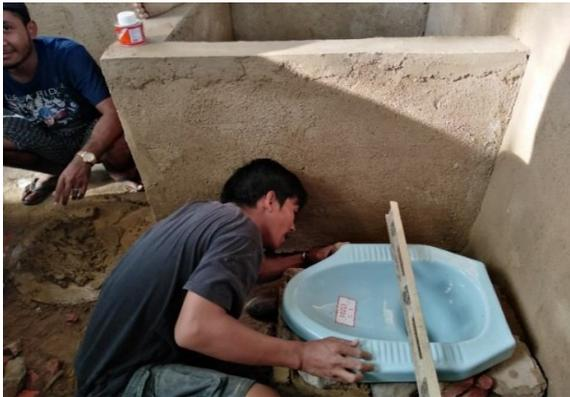
**Gambar 3** Proses Pemasangan Kloset
