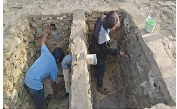
**Gambar 5** Pembuatan Sepic tank
