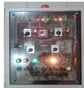
Gambar 15. Pengujian low oil genset pada Panel
