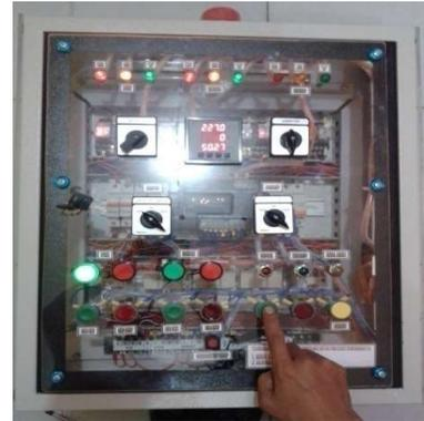
Gambar 12. Pengujian start engine secara manual
