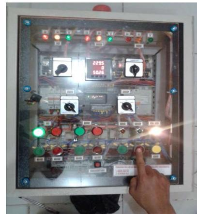
Gambar 13. Pengujian stop engine secara manual
