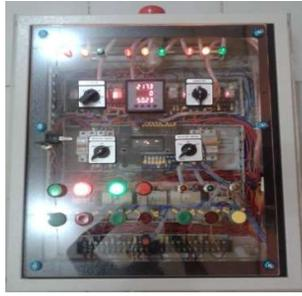
Gambar 14. Pengujian operasi otomatis pada Panel
